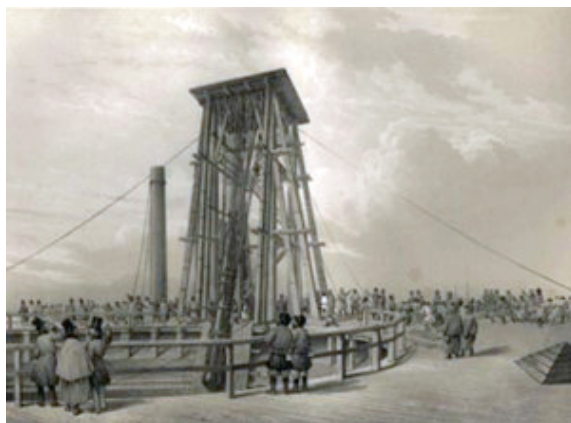
Установка колонн Исаакиевского собора
